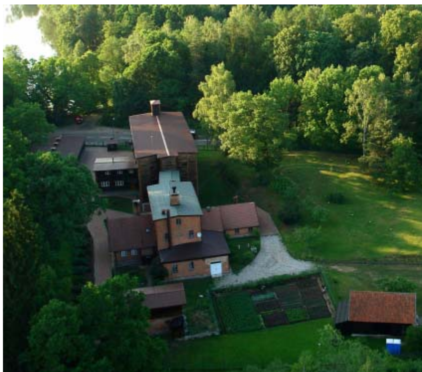
Ryc. 3. Widok Wyłuszczeni nasion w Rucianem-Nidzie – stan w 2006 roku (fot. Z. Opalach)
